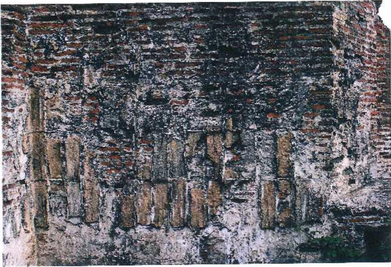
Figura 16 – I *tubuli* installati in parete per permettere la circolazione dell'aria calda
